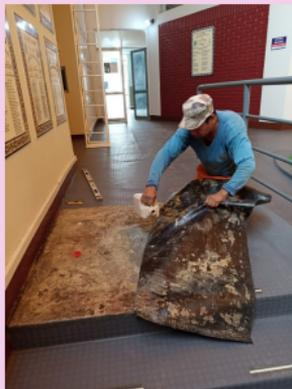
SE CONTINUA REALIZANDO TRABAJOS DE MEJORA: SE RETIRA EL PISO DE PLÁSTICO, PARA ARREGLAR EL PISO DE CONCRETO DEL PATIO "MIGUEL GRAU".
